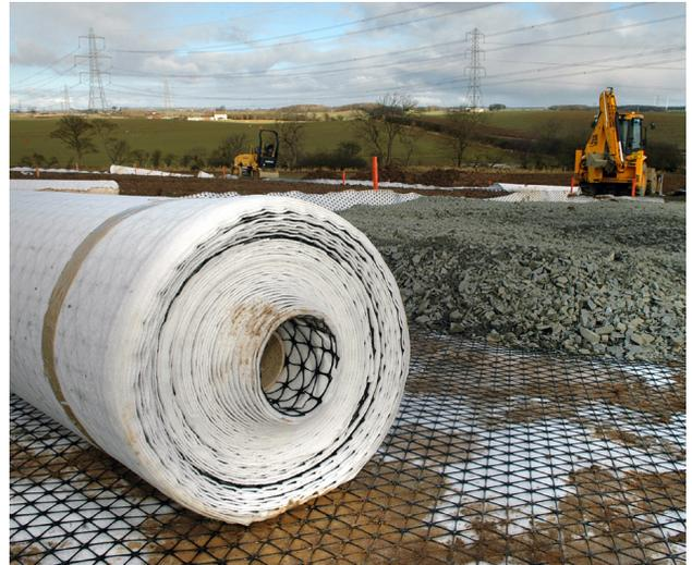
Las costillas de alto perfil y los nodos de la geomalla TriAx permiten la trabazón total del agregado cuando se combina con un geotextil no tejido.
