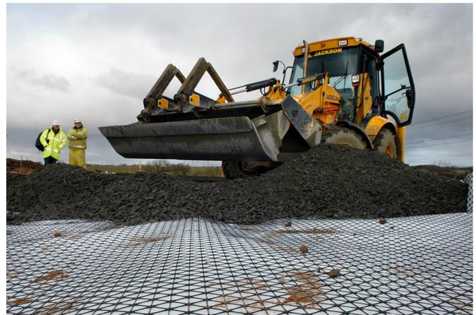
Las costillas y nodos de alto perfil de la geomalla TriAx permiten la trabazón total de los agregados cuando se combinan con un geotextil tejido ligeramente laminado.
