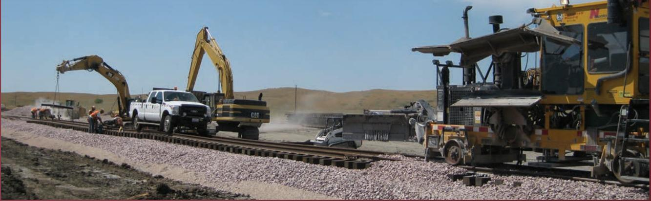
Colocación y compactación de balasto en una vía estabilizada con TriAx
