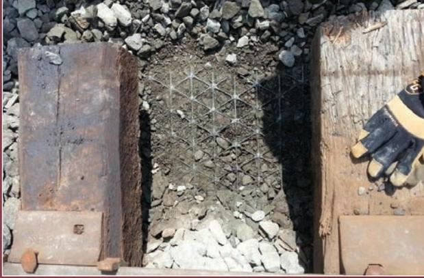
**IMAGEN A:** Se observa la Geomalla TriAx TX190 L en buenas condiciones sin daños mientras continúa soportando el balasto en la superficie.
