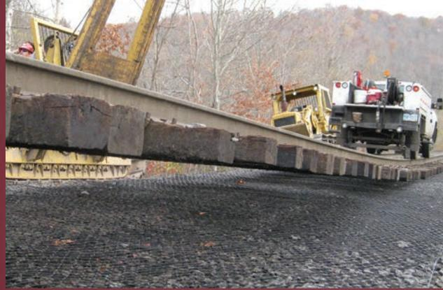
**IMAGEN D:** El riel existente se levanta para que la nueva geomalla y el balasto sean colocados.
