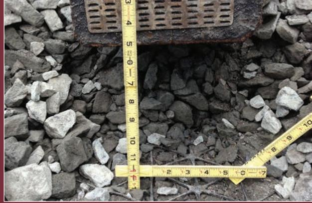
**IMAGEN B:** La Geomalla TriAx TX190 L puede resistir un proceso de instalación de balasto típico para vías férreas mientras reduce los intervalos de mantenimiento.
