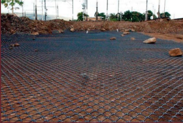
**IMAGEN C:** Para estabilizar el subbalasto bajo una nueva vía férrea, las geomallas se desenrollan directamente sobre la subrasante preparada.
