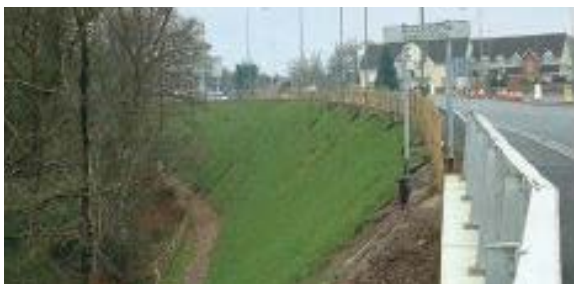
La vegetación se integra rápidamente en el entorno adhiriéndose a la fachada del talud terminado.
