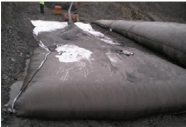
Los tubos de geotextil de Tensar® pueden retener, inclusive, materiales altamente orgánicos y de grano fino.
