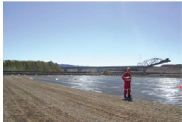
Las geomallas de Tensar proporcionan una capacidad portante adicional sobre sistemas de recolección de lixiviados para soportar cargas de equipos pesados.
