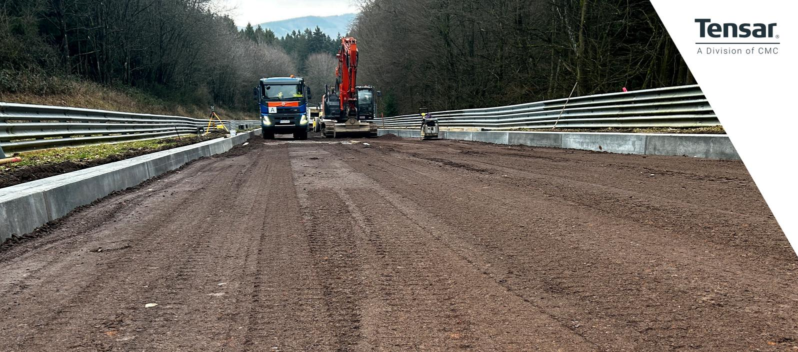
Tensor® InterAx® Geogitter erhöht die Tragfähigkeit
