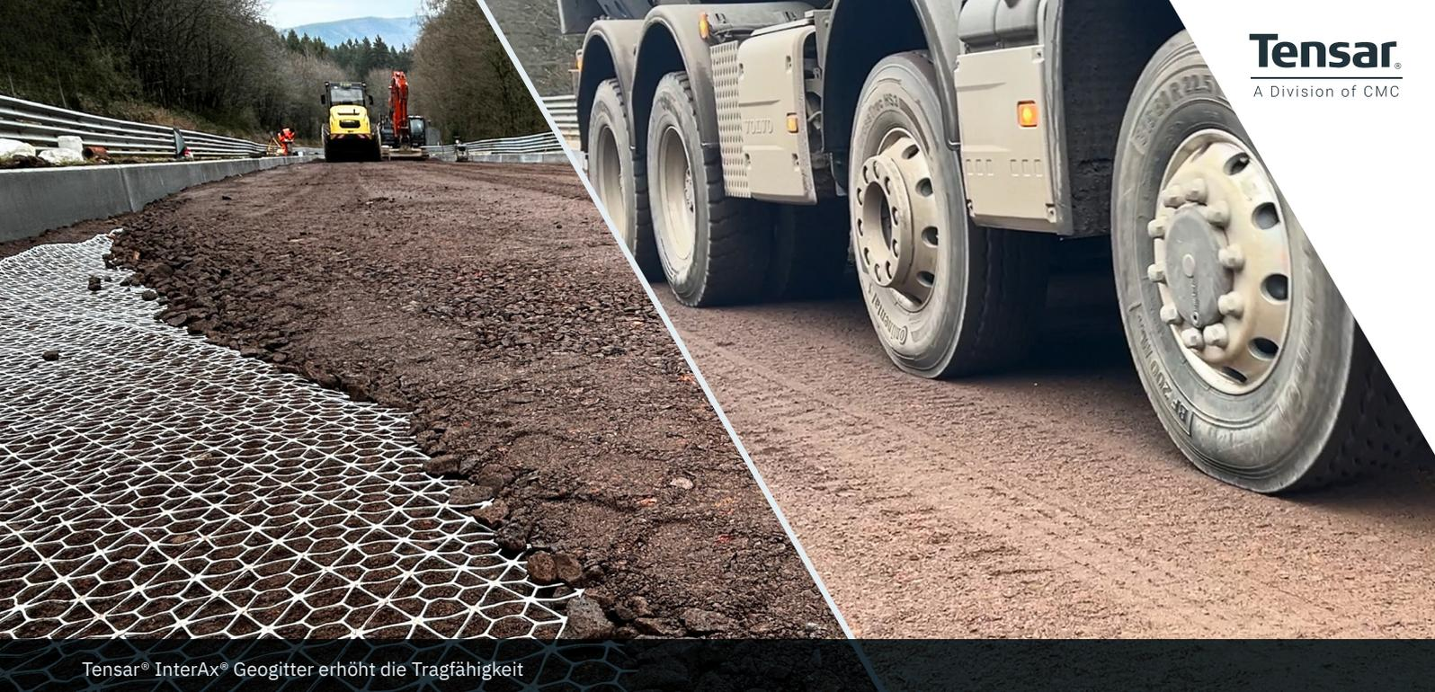
Tensor® InterAx® Geogitter erhöht die Tragfähigkeit
