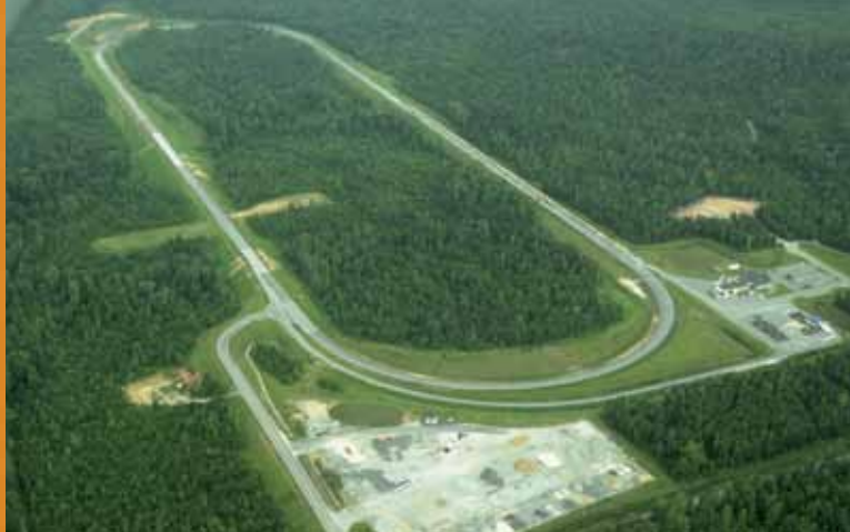
IMAGEN B: El sistema GlasGrid se instaló en la pista de pruebas de pavimento del Centro Nacional de Tecnología del Asfalto (National Center for Asphalt Technology, NCAT) en Opelika, Alabama.
