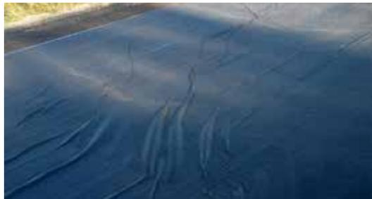
Imagen 5: Las arrugas mayores de 25 mm deben ser cortadas y traslapadas en la dirección de la pavimentación.
