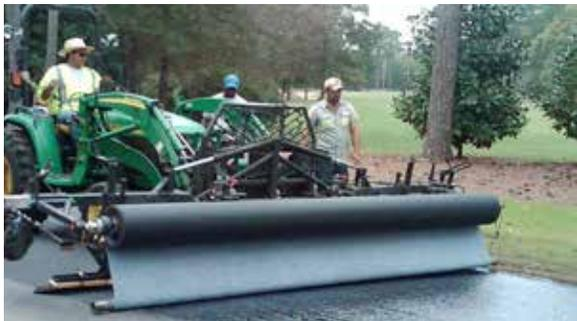
Imagen 1: Equipo de colocación de capas intermedias
