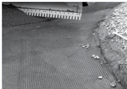
**IMAGEN 4:** Colocación de la geomalla TriAx Tensar para adaptarla a las curvas.
