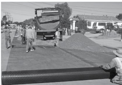
**IMAGEN 3:** La geomalla TriAx Tensar debe traslaparse en dirección al avance del relleno.
