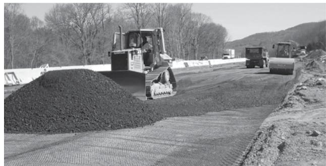
**IMAGEN 8:** Distribución del relleno de agregado sobre la geomalla TriAx Tensor.
