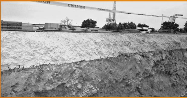
**IMAGEN 12:** Una excavación con retroexcavadora a través de geomalla TriAx Tensar.
