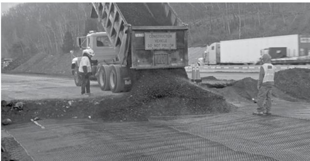
**IMAGEN 7:** Descarga por extremo de relleno de agregado sobre la geomalla TriAx Tensor encima de una subrasante blanda.
