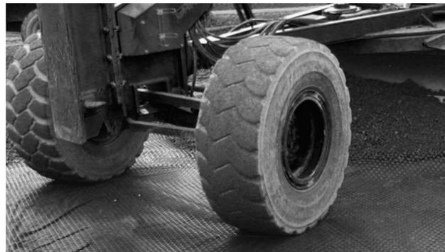
**IMAGEN 11:** Las geomallas TriAx Tensar pueden soportar el tráfico directo de equipo de neumáticos.
