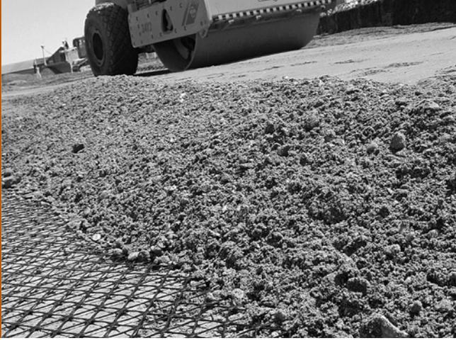
**IMAGEN 10:** Compactación del relleno de agregado.
